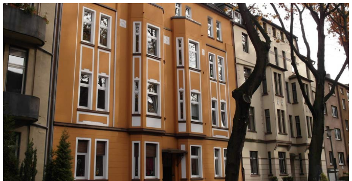
Altbaubestand an der Yorckstraße (Fotos: Daniel Heinrich)
